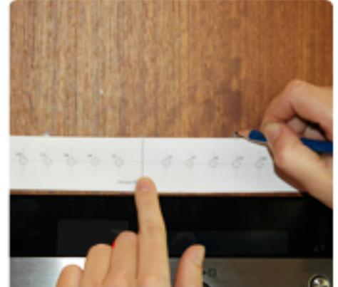
3- Positionnez le gabarit de perçage sur le pointage du centre de la poignée et pointez l'entraxe
